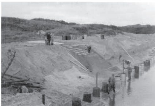
Tagkonstruktionen blev lavet som en meget simpel konstruktion, hvor træskelletet blev støbt fast i olietønder og derefter beklædt med tagpap.
