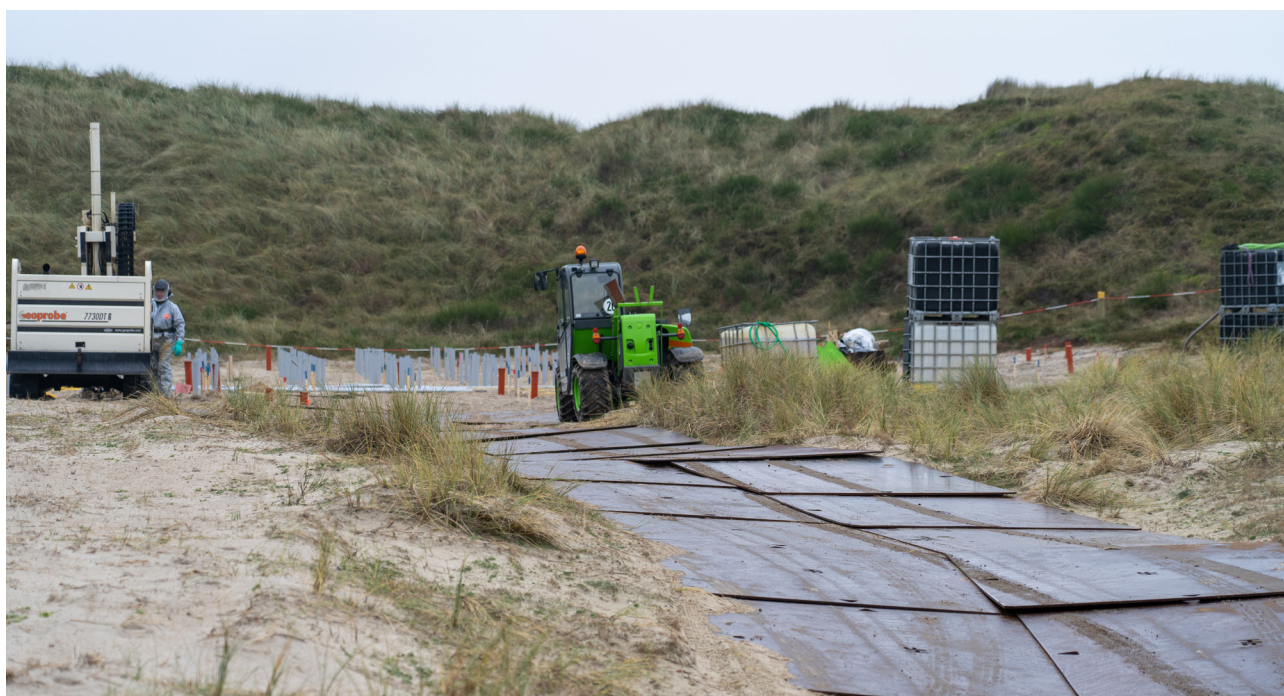
Arbejdere i beskyttelsesdragter og med friskluftmasker borer ned i gruberne i Kærgård.
